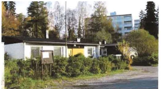
Ruotulan kerrostaloaluetta Tornimäenkadulta ja pientaloaluetta Pokalankadulta. As Oy Ruotulan Tornit muodostaa yhtenäisen kokonaisuuden, jossa myös rakennusten alkuperäinen, taloittain vaihteleva väriero on onnistuttu säilyttämään.
