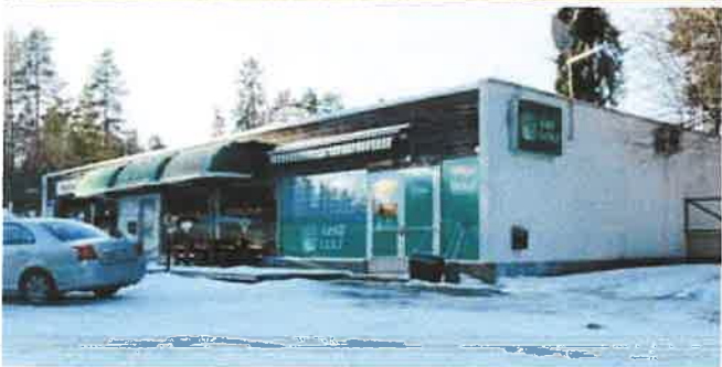
Ruotulan ostoskeskus ennen ja nyt. (lähteet: Aarre Mattisen valokuvakokoelma / Rakennusliike Mattinen & Niemelä Oy ja Tampereen kaupunki / rakennusvalvonta)
